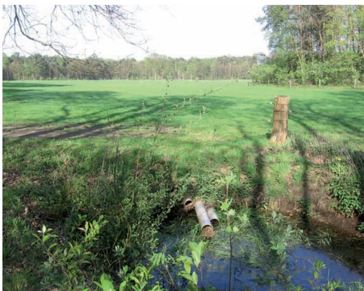
Door deze duikers af te sluiten, krijgt de beek binnenkort de ruimte om over het perceel te stromen.
