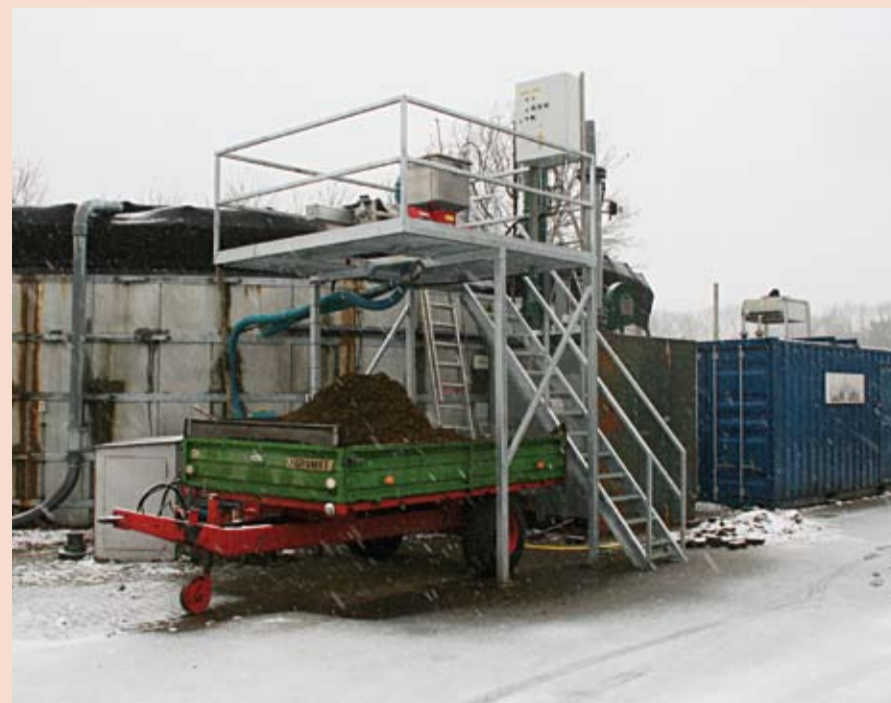
De mestscheider staat op een plateau. Vanaf het plateau valt de dikke fractie nu nog in een kiepwagen. Binnenkort komt er een sleufsilo voor de opslag van de dikke fractie.
